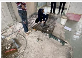
樓地板復原植筋拉拔測試
