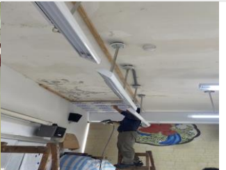
三樓自然教室壁癌修繕
