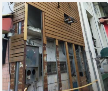
10/8 警衛室旁格柵進行 更新工程
