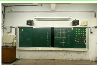
電力改善照片 1
