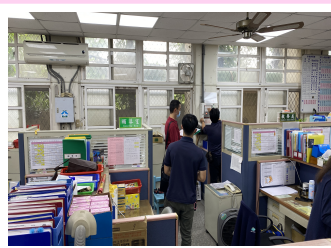
消防設備檢測
