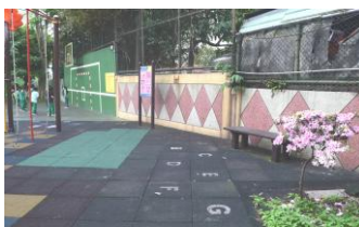
兒童遊戲區地墊修繕完工
