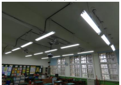
全校更新 LED 照明設備
